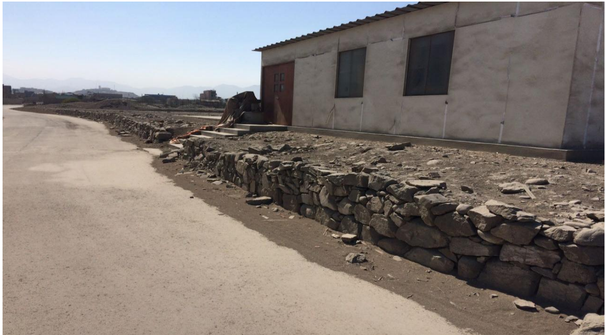
FOTOGRAFIA 02: VISTA DE LAS COSNTRUCCIONES EXISTENTES.
