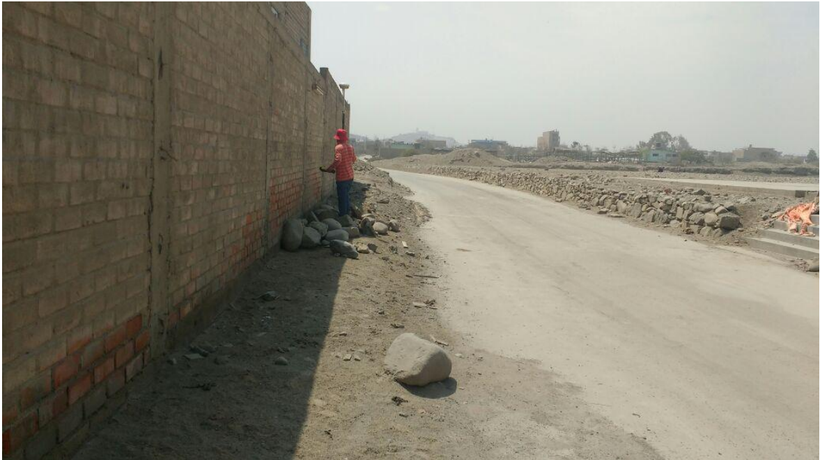
FOTOGRAFIA 02: LEVANTAMIENTO TOPOGRAFICO DEL MURO EXISTENTE.
