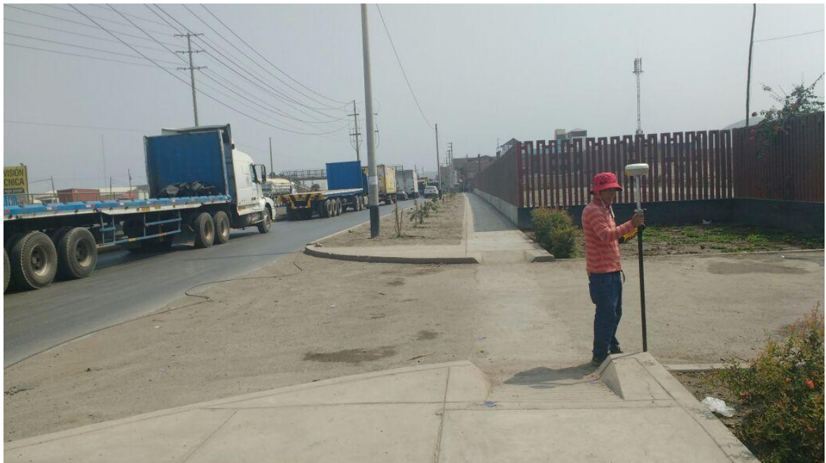
FOTOGRAFIA 02: VISTA DEL LEVANTAMIENTO TOPOGRAFICO DEL INGRESO DE LA PROPIEDAD.
