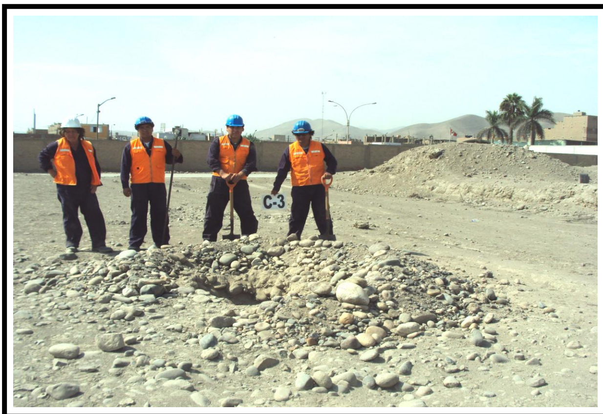
Fotografía 06 : Vista Exterior de la Calicata (C-3). Se Puede Apreciar el Material Excavado Constituido por Grava Pobremente Graduada con Arena y Cantos (GP).
