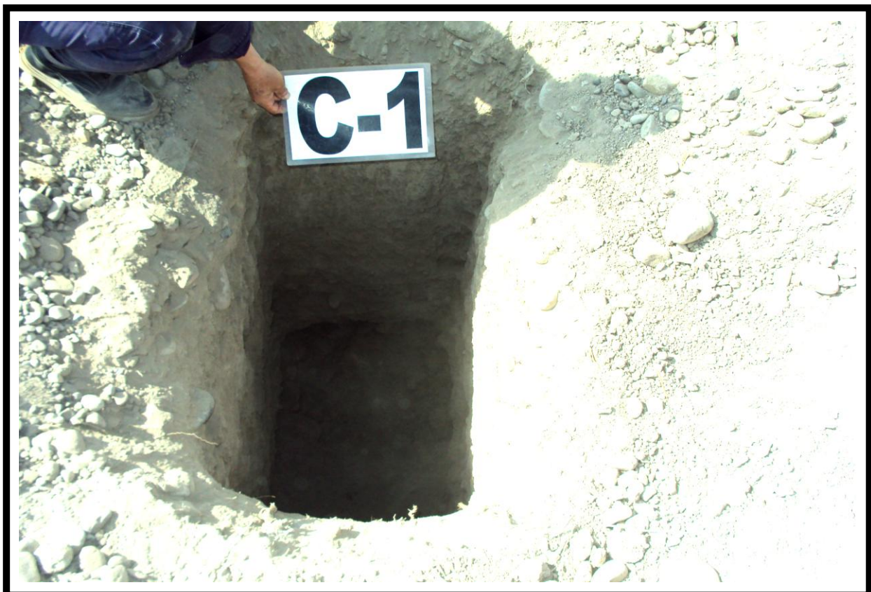
Fotografía 04 : Vista Interior de la Calicata (C-1). Se Puede Apreciar en el Fondo de la Excavación el Subsuelo Constituido por Grava Pobremente Graduada con Arena y Cantos (GP).
