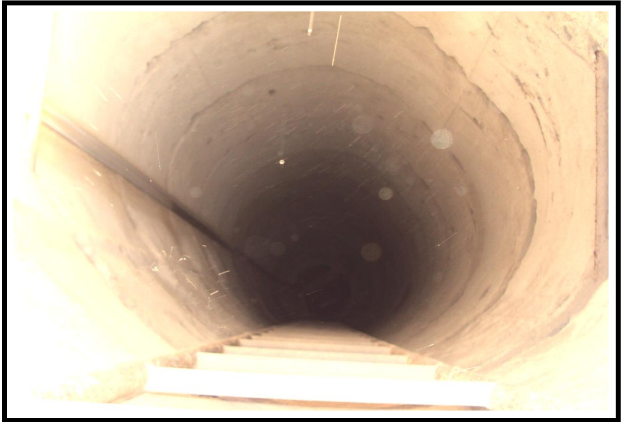
Fotografía 15 : Vista Interior del Pozo de Agua en el Área de Estudio. Se Puede Apreiciar el Nivel Freático Aproximadamente a 15.00 Metros de Profundidad.
