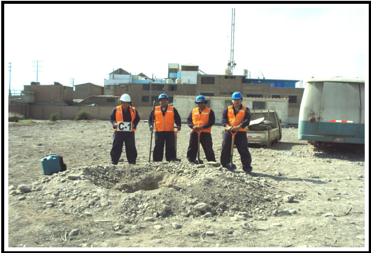
Fotografía 03 : Vista Exterior de la Calicata (C-1). Se Puede Apreciar el Material Excavado Constituido por Grava Pobremente Graduada con Arena y Cantos (GP).
