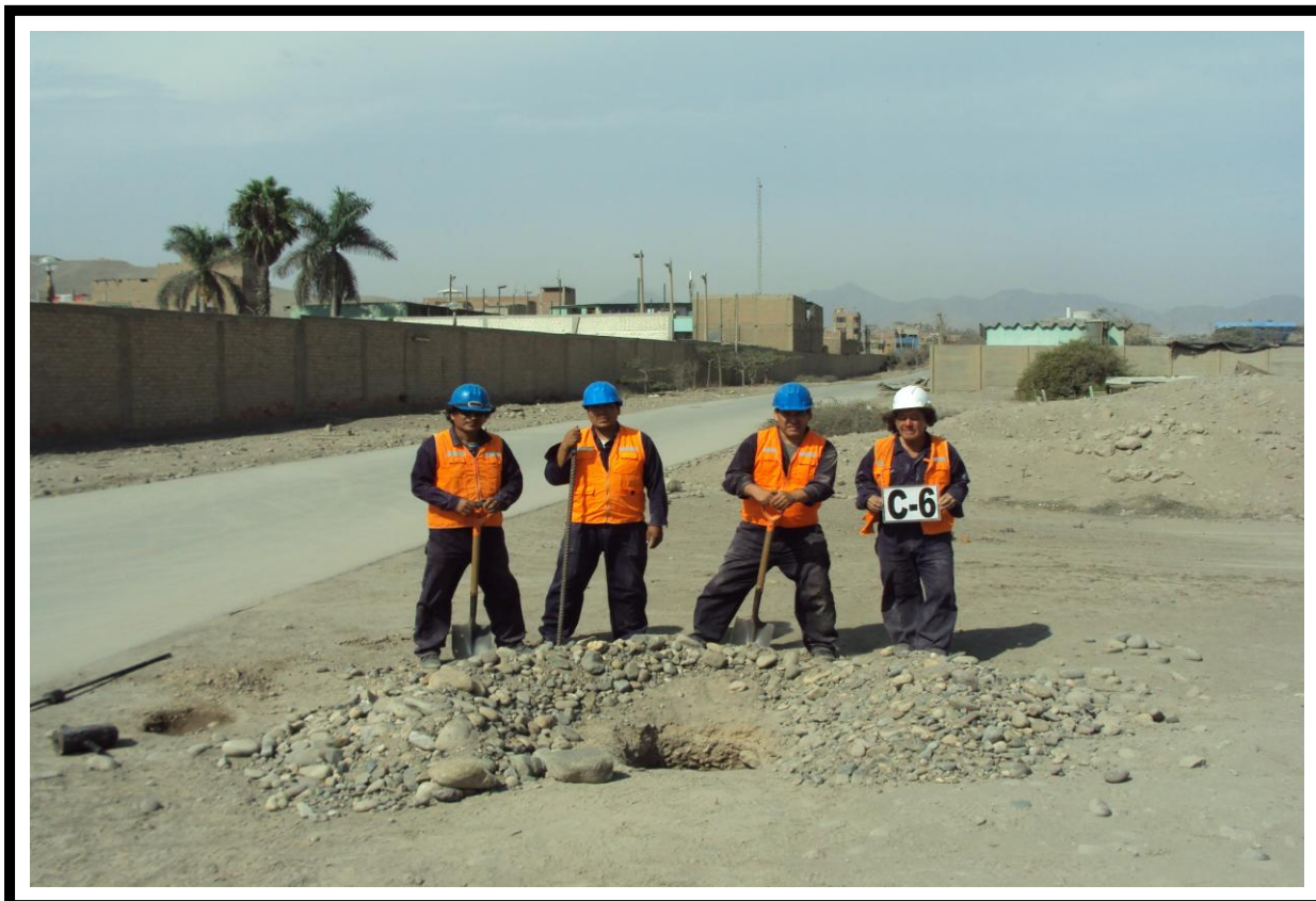
Fotografía 09 : Vista Exterior de la Calicata (C-6). Se Puede Apreciar el Material Excavado Constituido por Grava Pobremente Graduada con Arena y Cantos (GP).
