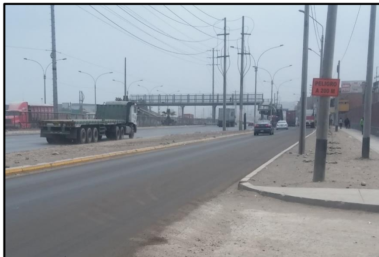
Imagen N° 14. Puente peatonal que cruza la Av. Néstor Gambetta en el frontis del predio y las instalaciones de la UNFV que llega hacia la berma lateral.
