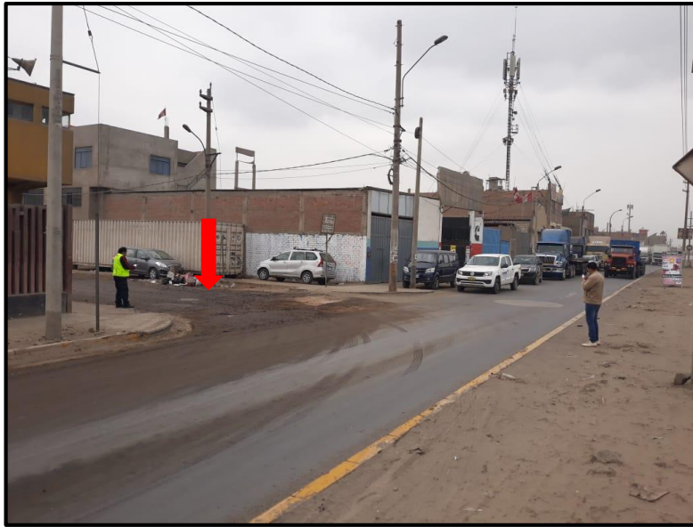
Calle H sin pavimentar
