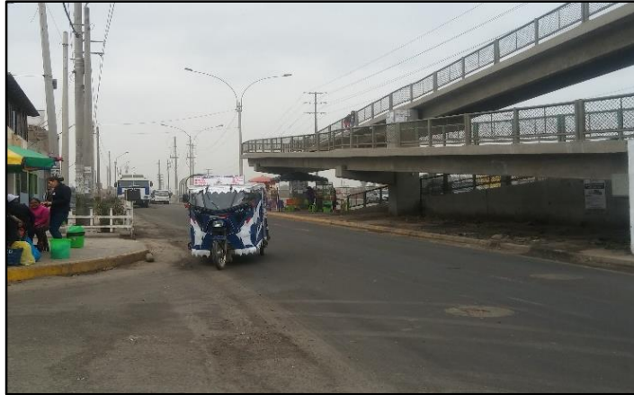
Imagen N°12. Vista del puente peatonal que cruza la Av. Néstor Gambetta en las bermas laterales.
