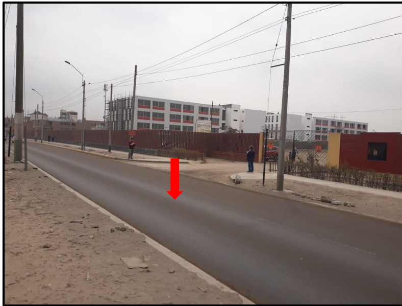
Falta de Mantenimiento a la señalización Horizontal
